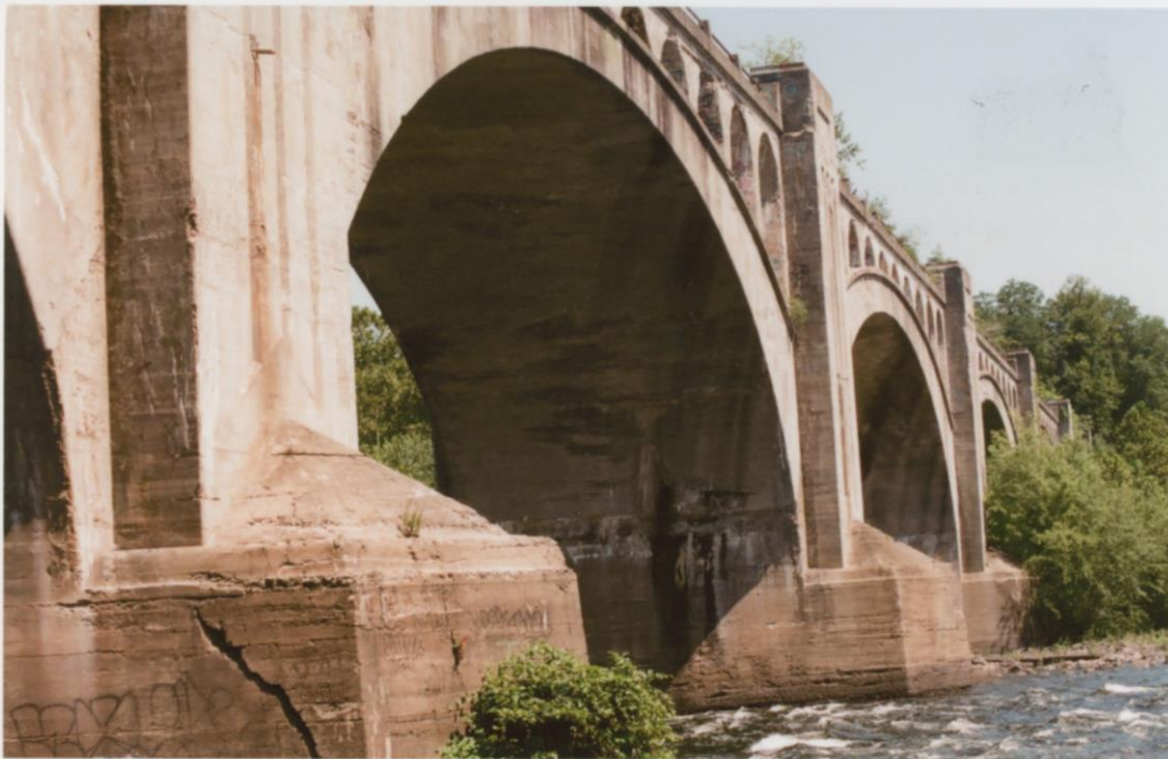
8.13.21 PA. END, DELAWARE VIADUCT S. SIDE
