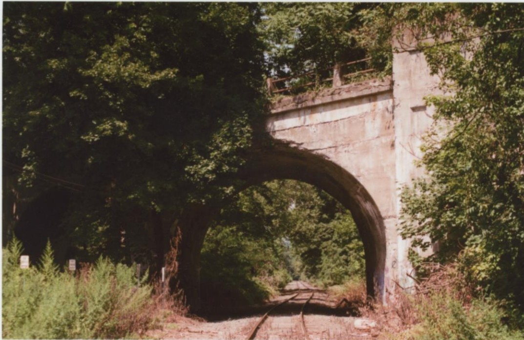
8-13-21 PA. END DELAWARE VIADUCT N.S. TRACK
